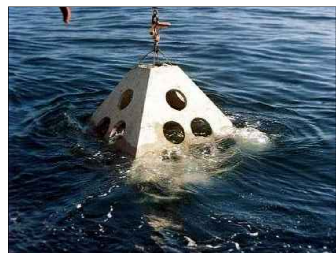
REEF CONICI BARRIERA TIPO F - PREFABBRICATA
